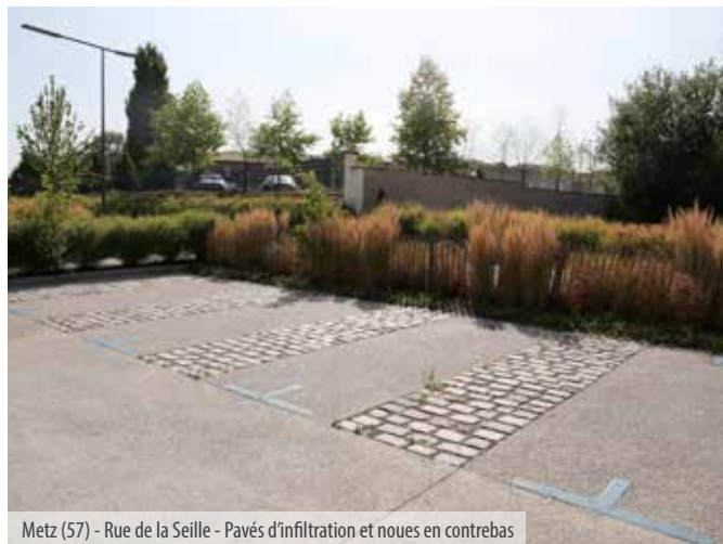
Metz (57) - Rue de la Seille - Pavés d'infiltration et noues en contrebas
