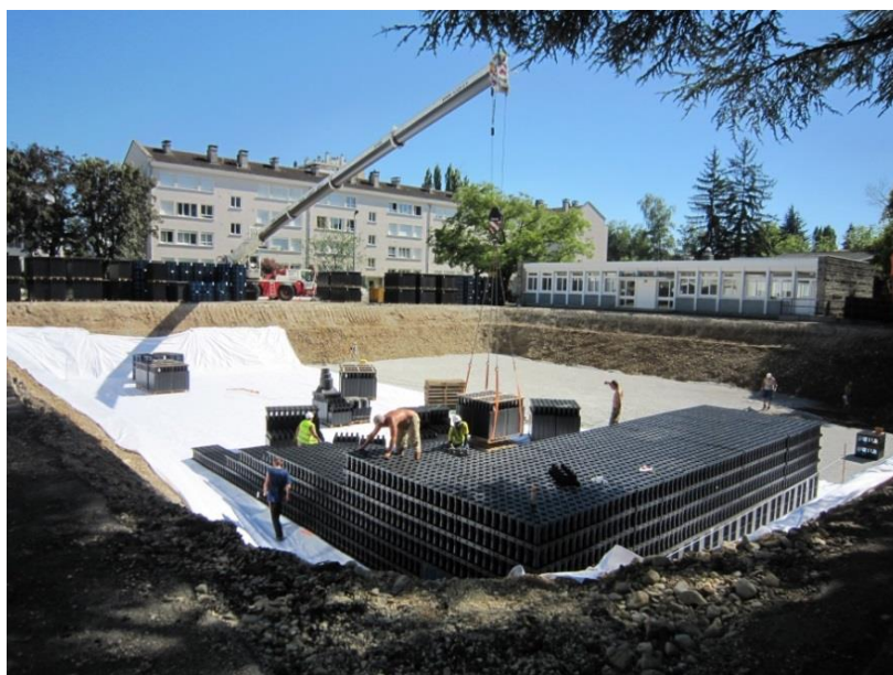
Mise en place du bassin d'infiltration sous l'école de la plaine
