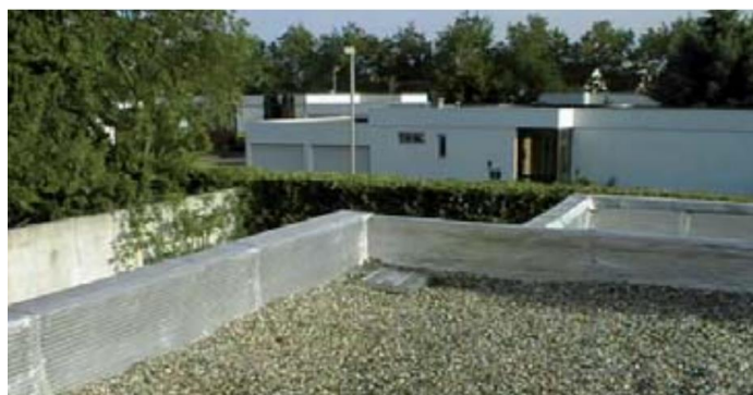
Figure 51 : Toiture-terrasse stockante (Communauté Urbaine du Grand Lyon, 2008)
