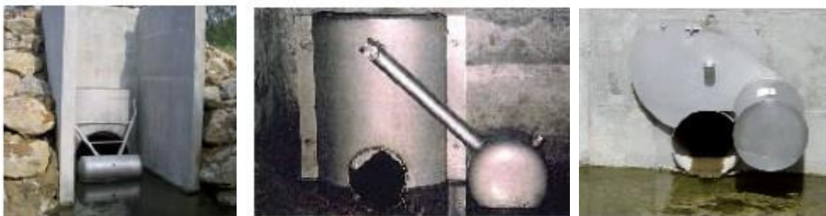
Figure 126 : Régulateurs à flotteur (Saint Dizier environnement)
