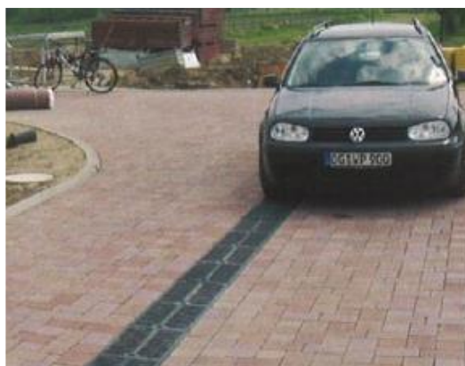
Figure 48 : Exemple de caniveau filtrant infiltrant (Funke)
