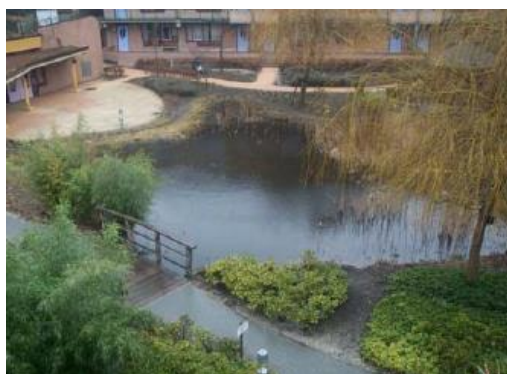
Figure 44 : Marre d'infiltration (Rombaut, 2010)
