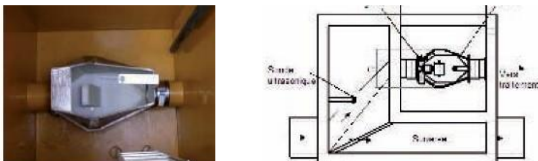
Figure 132 : Vanne de régulation (Saint Dizier environnement)
