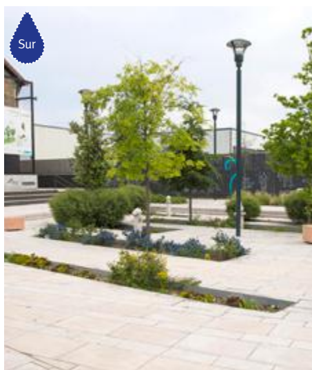
ROMAINVILLE : ESPACE VÉGÉTALISÉ INFILTRANT EN DÉCAISSÉ DE L'ESPACE PUBLIC. Source : Est Ensemble / Gaël Kerbaol
