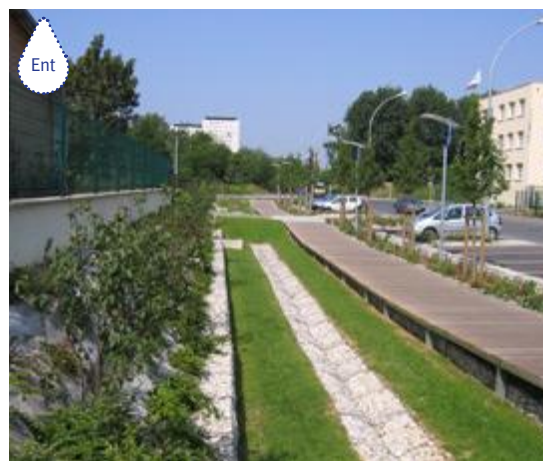
CLICHY-SOUS-BOIS (93) : PARC D'ACTIVITÉ - TRANCHÉE DRAINANTE POUR LE RESSUYAGE DE LA NOUË.
