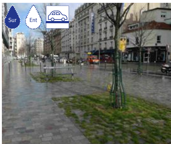
RUE CARDINET : REVÊTEMENT PERMÉABLE EN PIED D'ARBRE. Source : © APUR
