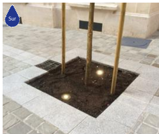
FOSSE D'ARBRE DÉCAISSÉE - NEUILLY (92). Source : ATM
