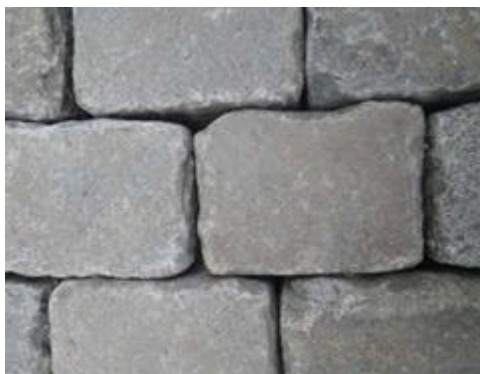
PAVAGE CORRECTEMENT POSÉ : LES PAVÉS SE TOUCHENT.
