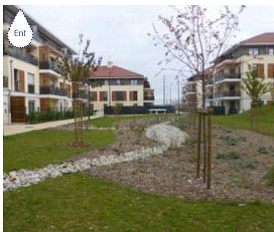
MAGNANVILLE (78) : RÉSIDENCE DES MANGAZONS : TRANCHÉE DRAINANTE CONNECTÉE À UN SYSTÈME DE PUIITS D'INFILTRATION - STOCKAGE PAYSAGER.
