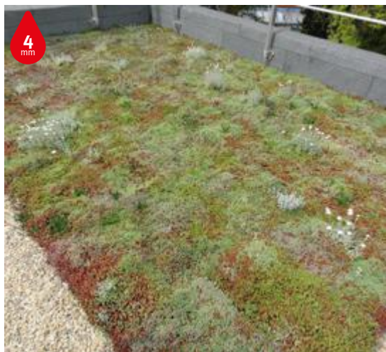
TOITURE VÉGÉTALISÉE - SHOW ROOM OFFICE INTERNATIONAL DE L'EAU
