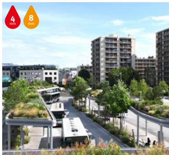
TOITURE VÉGÉTALISÉE EXTENSIVE À RUEIL MALMAISON (92)
