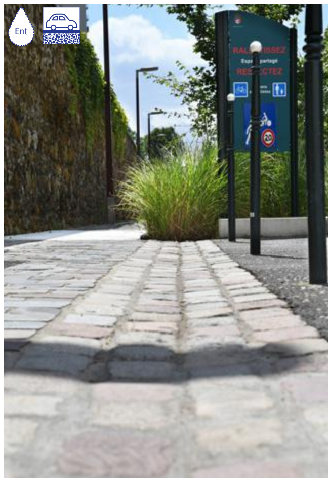
CANIVEAU INFILTRANT RUE SŒUR VALÉRIE, VILLE D'ASNIÈRES.
