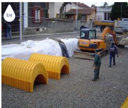
VAL DE MARNE : BASSIN EN STRUCTURES ALVÉOLAIRES.
