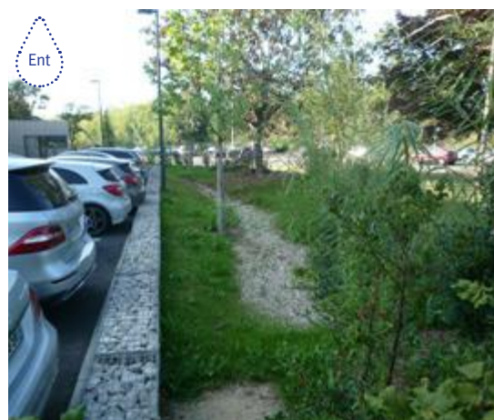
MONTIGNY-LE-BRETONNEUX (78) : TRANCHÉE D'INFILTRATION ET ALIMENTATION PAR BORDURE « GABION » DRAINANTE STOCKAGE PAYSAGER.
