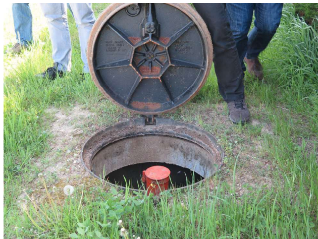
Fig. 23. Piézomètres sur le site du bassin d'infiltration de Feyzin
