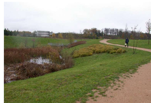
Exemple du bassin d'infiltration des eaux pluviales de Minerve sur la Métropole de Lyon
