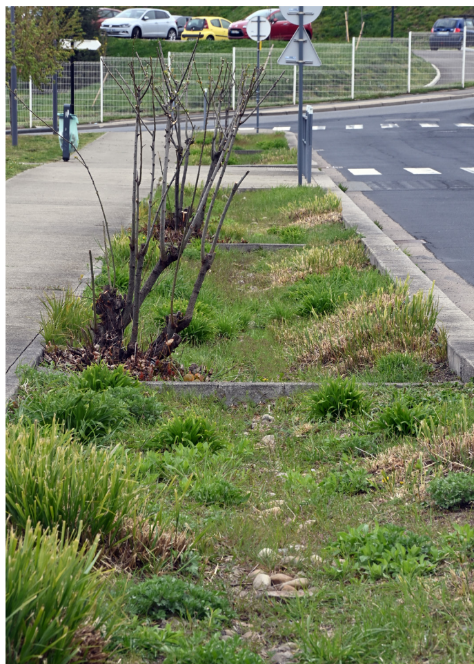
Exemple de tranchée drainante - Saint-Étienne
