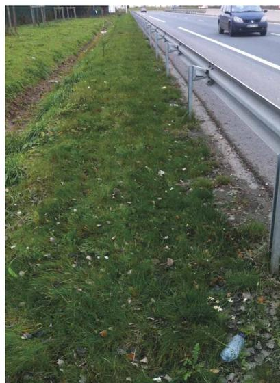
Figure 6. Accotement filtrant.
