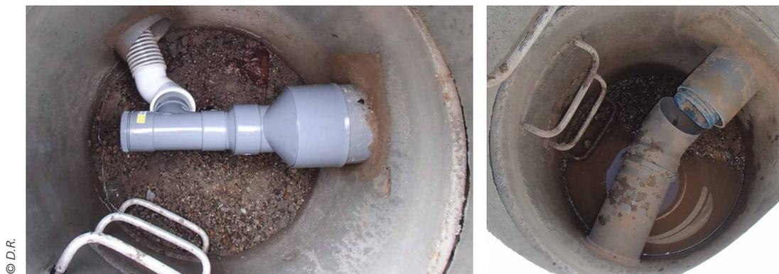
Figure 7. Connexion refaite dans le regard.
