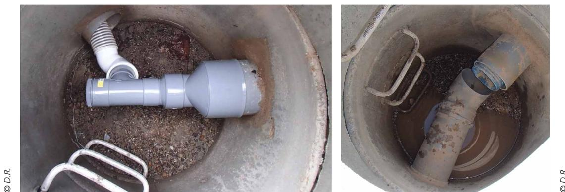
Figure 7. Connexion refaite dans le regard.
